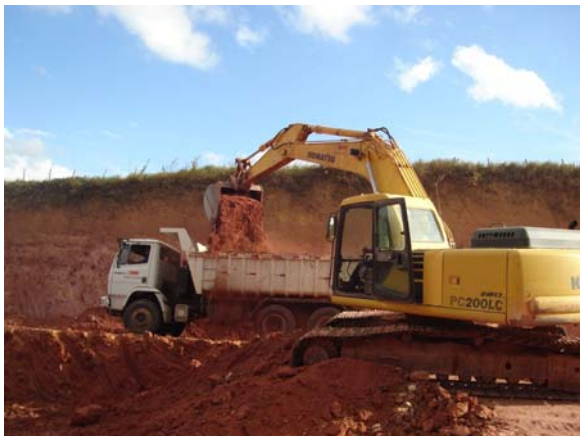
Foto 3: outubro/2006 - ECT executada com escavadeira e caminhões.
