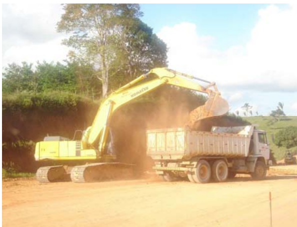
Foto 1: agosto/2006 – ECT executada com escavadeira e caminhões.
