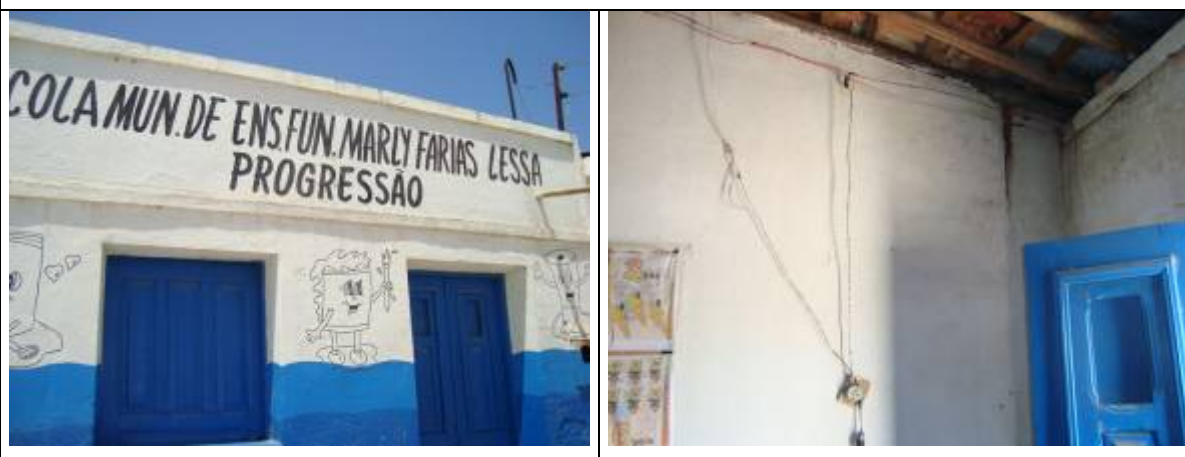
Registro Fotográfico 02: Escola Marly Farias Lessa
