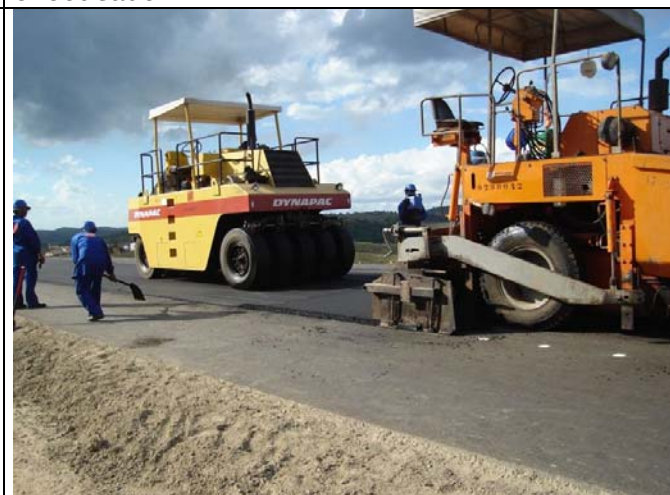
Foto 04: Execução do CBUQ da pista de rolamento antes do TSD do acostamento.
