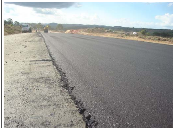
Foto 03: Execução do CBUQ da pista de rolamento antes do TSD do acostamento.
