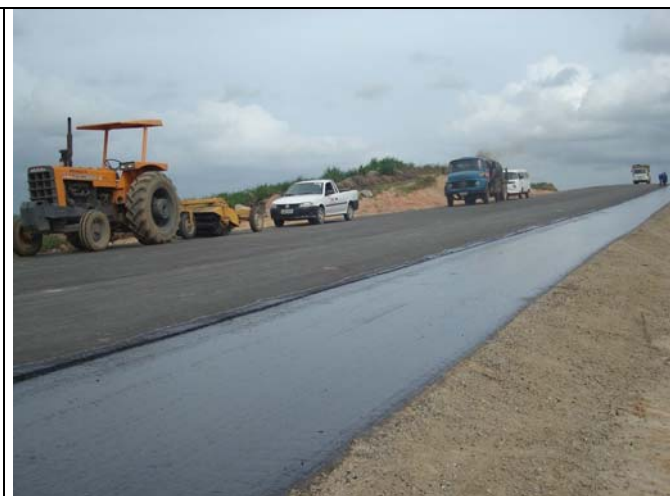
Foto 02: Pista de rolamento em CBUQ já executada e TSD do acostamento ainda não executado.
