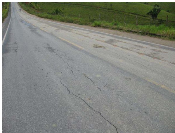
Fotos 05 e 06: Trincas prematuras no pavimento – km 8,5.
