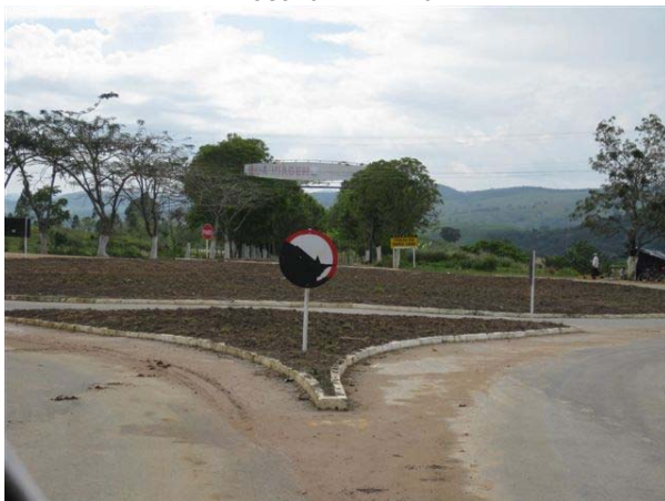
Foto 03: km 0 (acesso Ibateguara)
