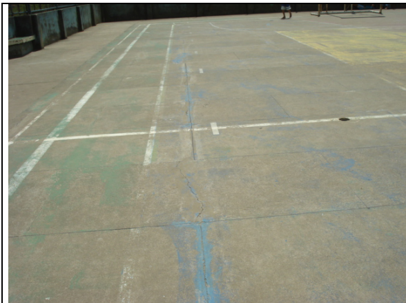
Rachaduras no piso da quadra do Povoado Canastra.
