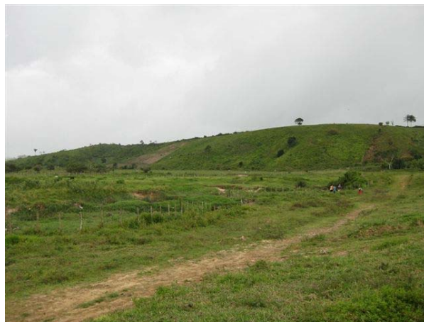
Foto 02: J2 - a 1,2km da Estaca 430 - km 8,6 - LE (material utilizado p/ base)
