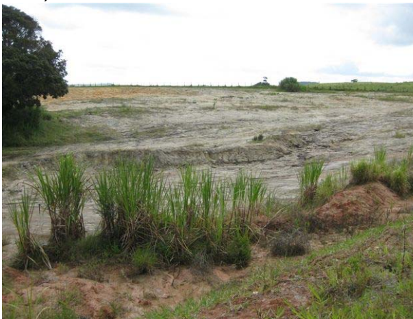
Foto 7: J3 - Estaca 740 - km 14,8 - LE (material utilizado para base e sub-base)
