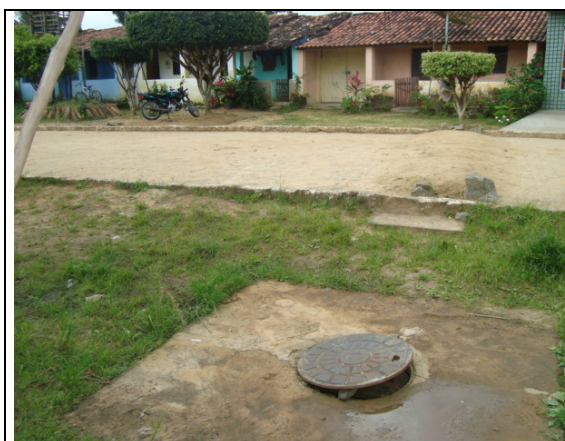
Poço de visita no passeio.
