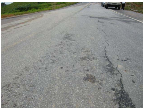
Fotos 05 e 06: Trincas prematuras no pavimento – km 8,5.
