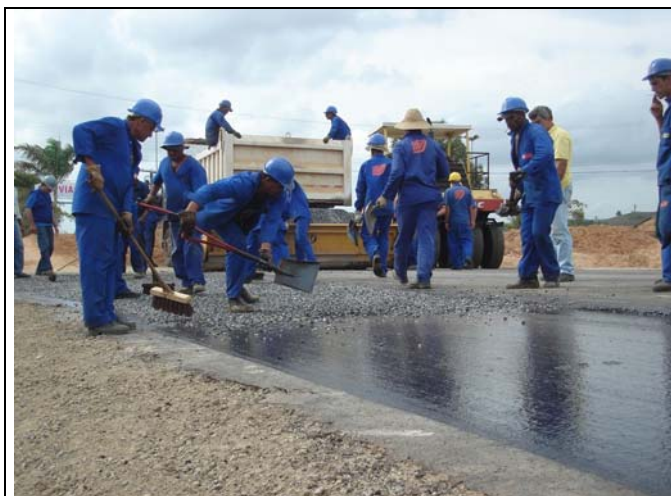
Foto 01: Execução do TSD do acostamento com CBUQ da pista de rolamento já executada .
