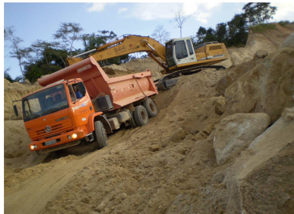
Foto 4: novembro/2008 - ECT executada com escavadeira e caminhões.
