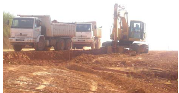
Foto 2: agosto/2006 – ECT executada com escavadeira e caminhões.
