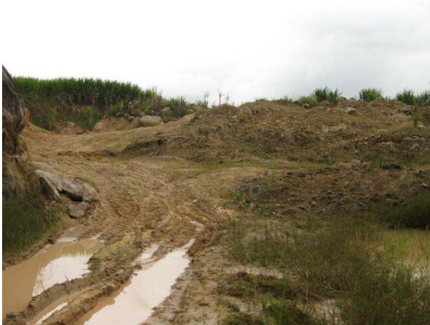
Foto 5 : J1 - a 7,0 km da Estaca 28 - km 0,6-LD (material utilizado para sub-base).
