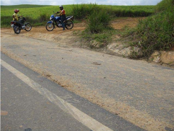
Foto 3: Estaca 28 - km 0,6 - LD - Interseção com a estrada de acesso à usina Controladoria-Geral da União
