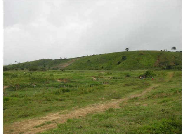
Foto 6: J2 - a 1,2 km da Estaca 430 - km 8,6 - LE (material utilizado p/ base).
