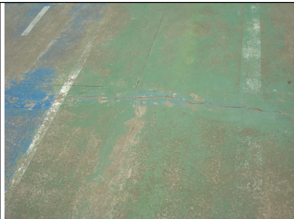
Rachaduras no piso da quadra do Povoado Canastra.
